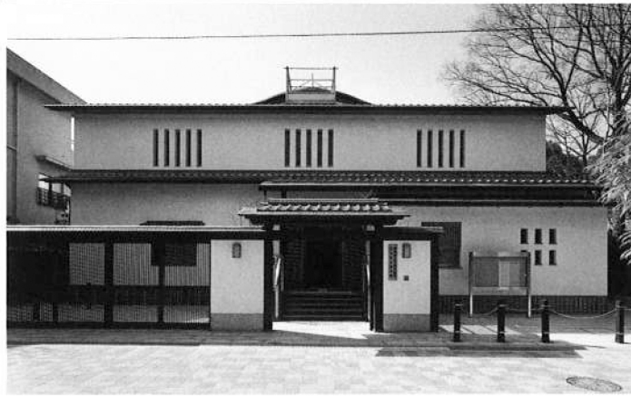
豊中市石塚会館・豊中市立伝統芸能館
